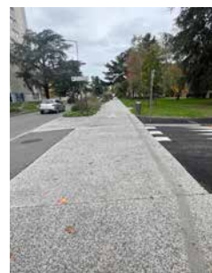
Traversée piétonne continue qui sécurise le piéton, l'enfant, le passant malvoyant et facilite la promenade des personnes en fauteuil roulant
